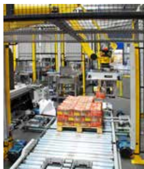
Monitorização de Movimentos Perigosos
